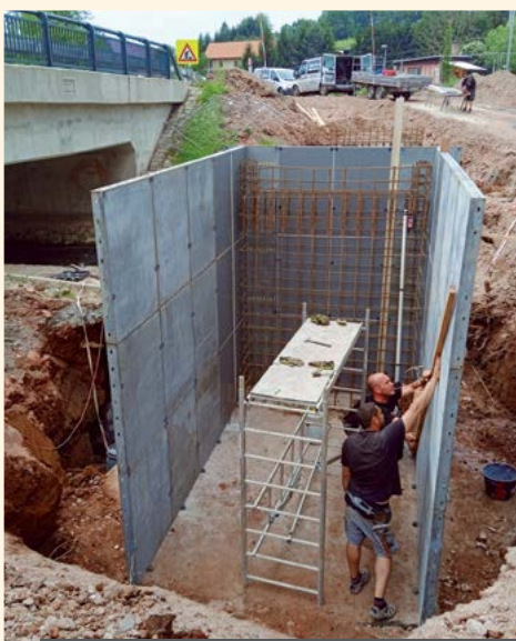
Výstavba lávky přes potok. Foto T. Voborník
