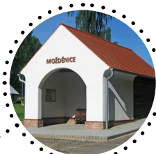
Vysočina, Pardubický kraj 2013, Přestavba autobusové zastávky
