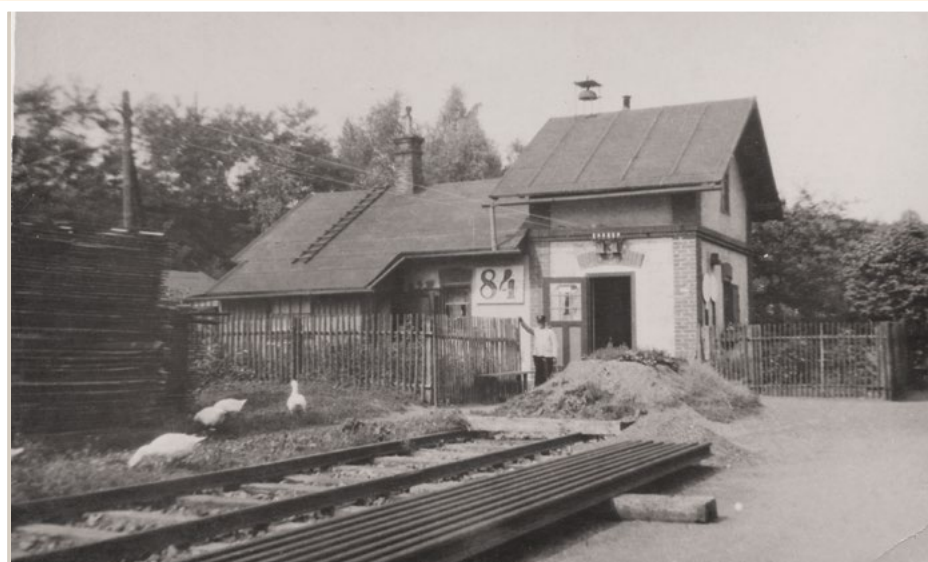
► Na snímku z roku 1937 je strážní domek u pilníkovského nádraží, který obývala rodina výhybkáře Marečka
